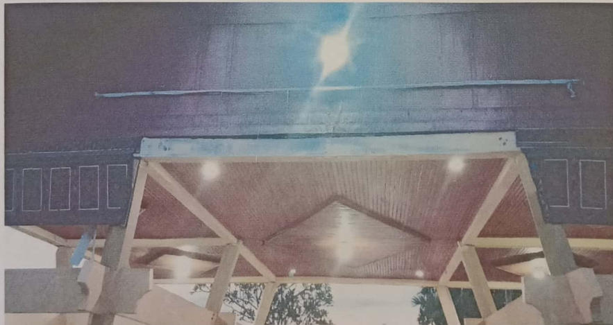
Foto Lampu Sorot Gerbang Taman Makam Pahlawan Kusuma Negara Padang setelah diperbaiki dan dipasang baru
